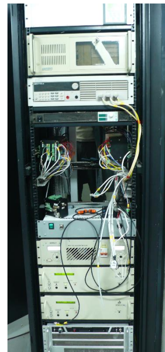
Система контроля и источники питания
