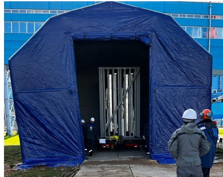
Перемещение ГМГ на площадку наблюдения
