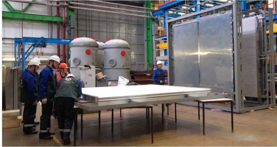
Сборка ГМГ в машинном зале
